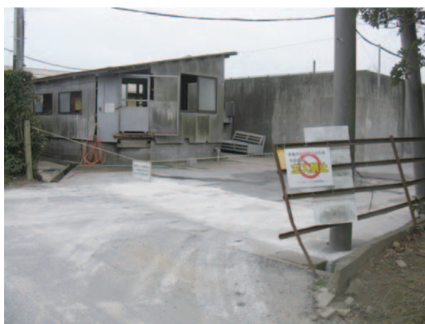
管理区域出入口
